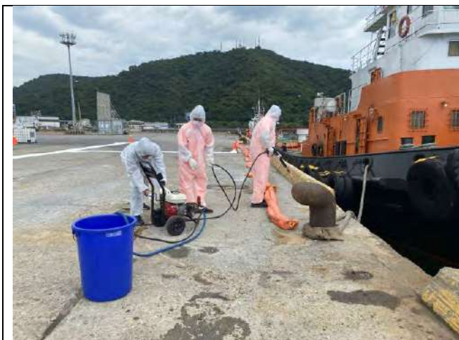
應變人員使用高壓清洗機清除岸際油污
