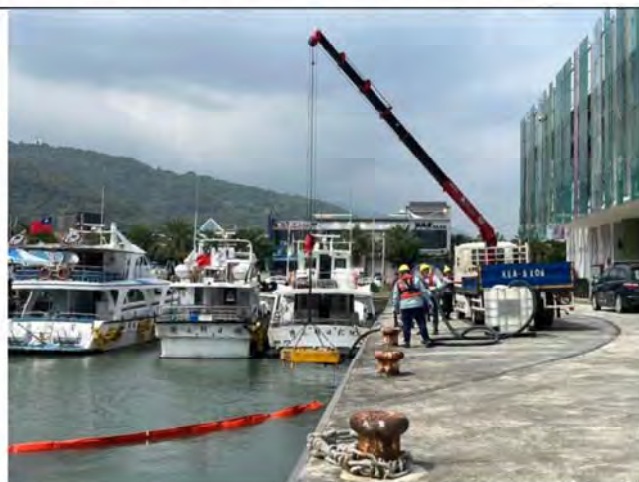
中油吊臂卡車以汲油器進行汲油
