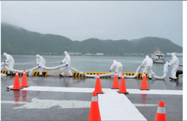
應變人員鋪設除污走道
